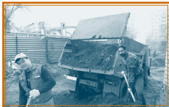
Erdarbeiten auf dem Kirchgrundstück
